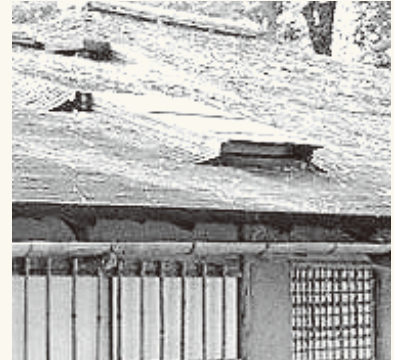
屋根面の突上げ窓
